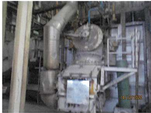
ภาพที่ 2 Two-Bed Regenerative Burner
