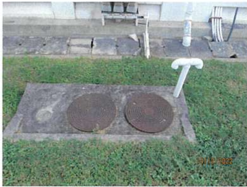
ภาพที่ 6 ระบบบำบัดน้ำเสียแบบไร้ออกซิเจน
