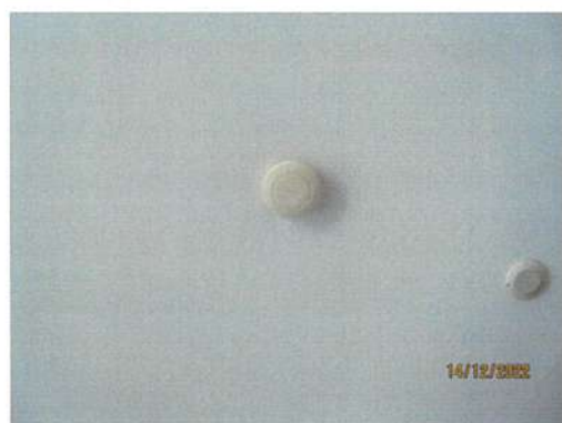
ภาพที่ 25 อุปกรณ์ตรวจจับควันและอุปกรณ์ตรวจจับความร้อน
