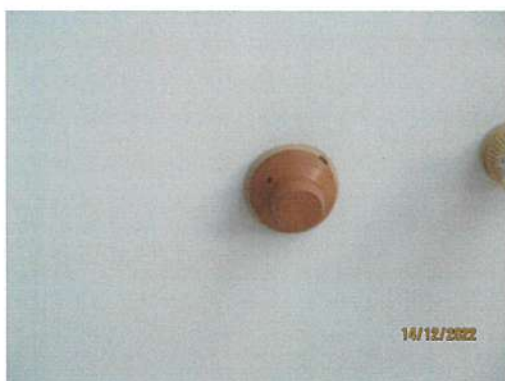
ภาพที่ 25 อุปกรณ์ตรวจจับควันและอุปกรณ์ตรวจจับความร้อน
